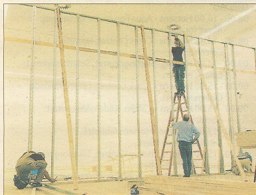
▲ Håndværkerne har haft travlt med at bygge skelettet til swimmingpoolen op.
