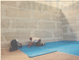
▲ Da poolens skelet var bygget op, begynde arbejdet med at skabe illusionen af swimmingpool.
